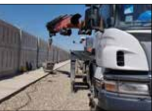
ساری - دهقان: مدیر منطقه ۹ عملیات انتقال گاز از احداث ایستگاه حفاظت کاتدیک دشت حلقه در روی خط سرخس - رامسر در محدوده مرکز بهره برداری خطوط لوله گرگان خبر داد.
