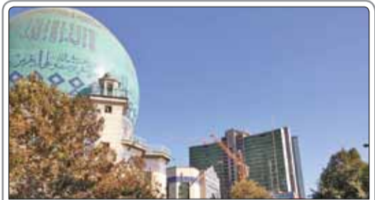
رزاموسوی، کارشناس میراث فرهنگی گفت: در سال‌های گذشته گنبد حسینیته ارشاد از داخل مرمت و بازسازی و سطح آن از داخل کاشی شد که این پارکداری دوباره نیز مزید بر علت شده و به همین دلیل به مرور شاهد ترک‌هایی در سطوح خارجی و داخلی بنا بوده و خواهیم بود
